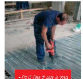
▲ Fig.15 Fase di posa in opera dei connettori Hilti X-HVB 95. ▶ Fig.16 Solaio in acciaio finito.
