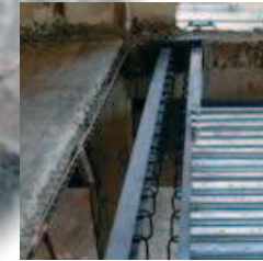
◀ Fig.8 Inghisaggio delle piastre flangiate. ▶ Fig.9 Fase di montaggio delle travi binata composte (ancora senza armature).
