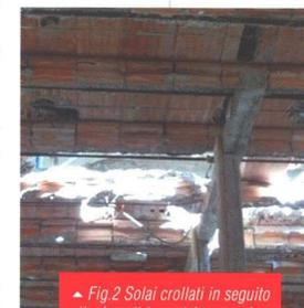
▲ Fig.2 Solai crollati in seguito alla demolizione dei tramezzi.
