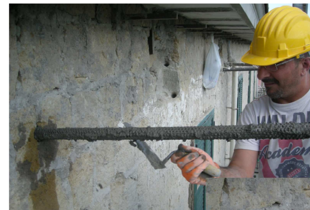
inserimento del paletto "PERFO" nel foro
