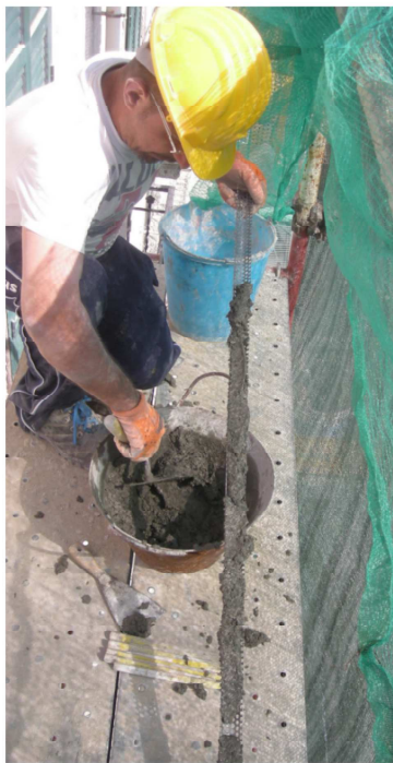
inserimento della malta nel paletto "PERFO"
