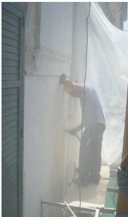
pulizia del foro dalle polveri
