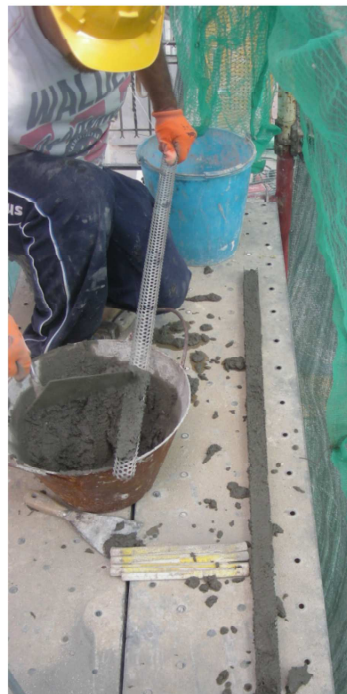
inserimento della malta nel paletto "PERFO"
