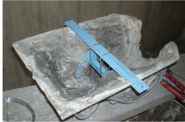
rinforzo del supporto e ancoraggio a vite
