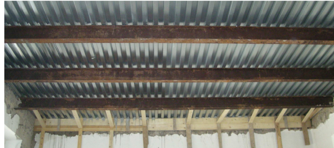
la nuova orditura secondaria in lamiere HI BOND
