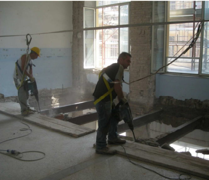
demolizione orditura secondaria
