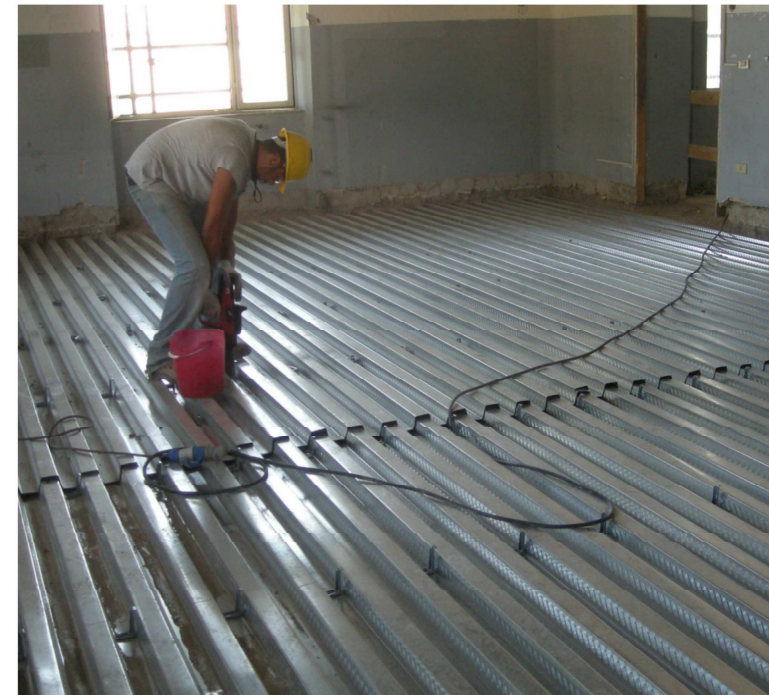
posa dei connettori all'estradosso delle lamiere HI BOND
