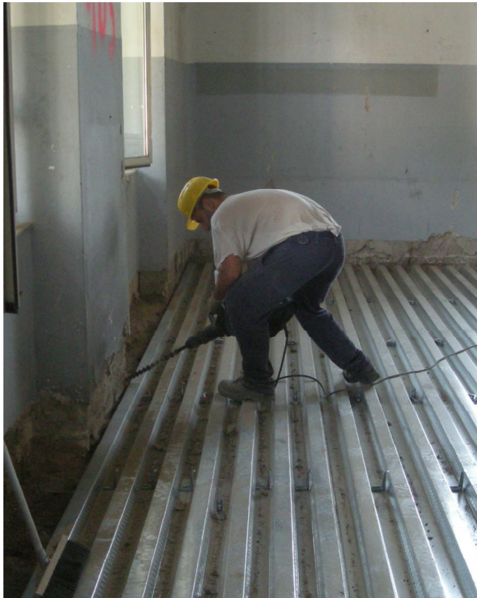
realizzazione fori a quota soletta per l'ancoraggio delle barre per il grip-round
