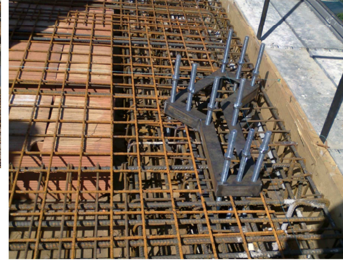
ancoraggi delle colonne in acciaio del tetto
