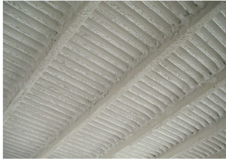
trattamento con vernice intumescente all'intradosso dei solai in acciaio
