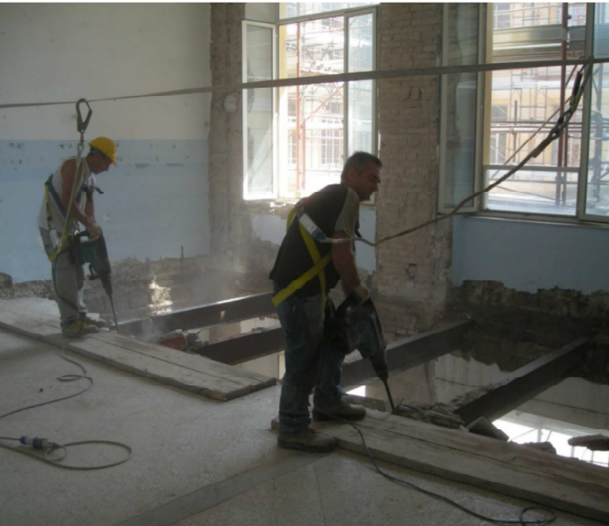
demolizione orditura secondaria
