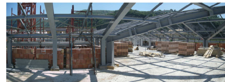
le colonne multiple d'angolo
