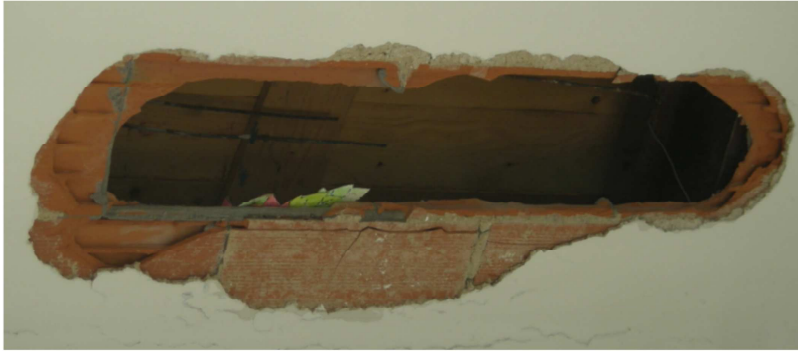
intradosso solaio preesistente
