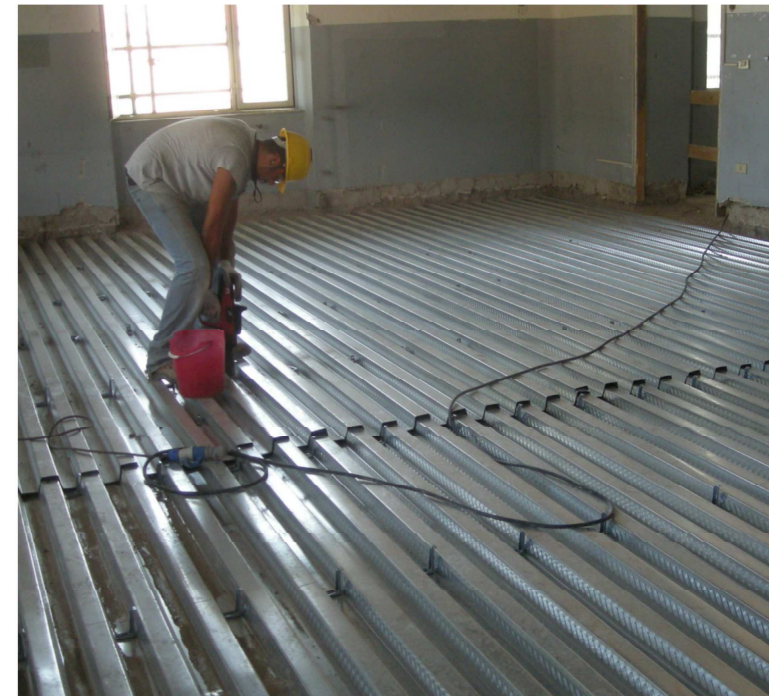
posa dei connettori all'estradosso delle lamiera HI BOND
