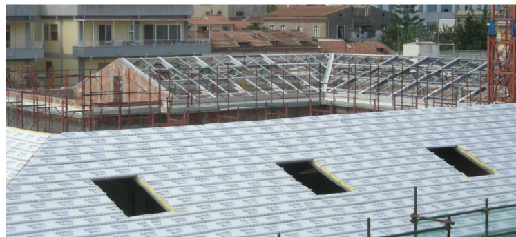
fase di montaggio dei pannelli
