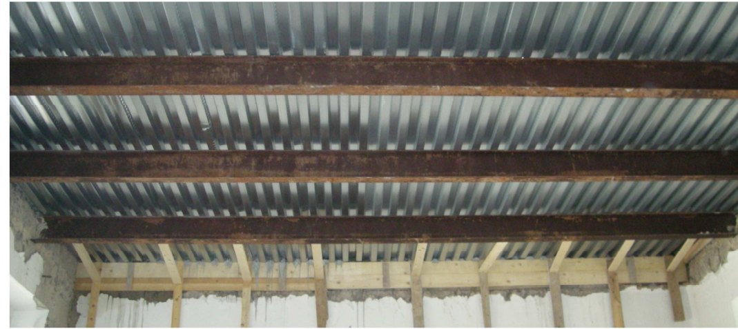
la nuova orditura secondaria in lamiera HI BOND
