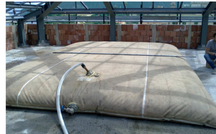
la prova di carico del solaio
