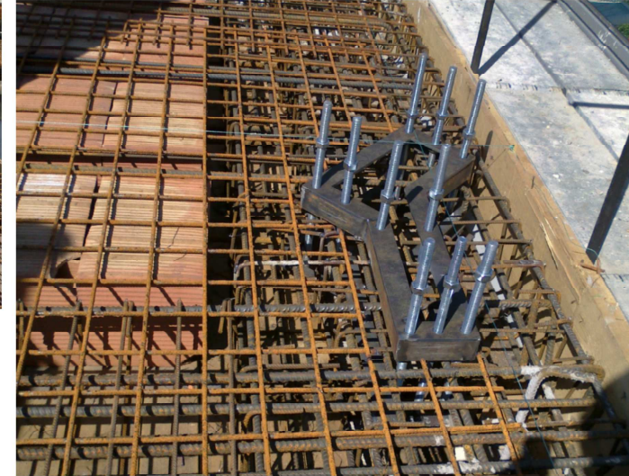
ancoraggi delle colonne in acciaio del tetto
