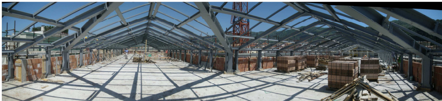
uno degli angoli della copertura padiglione
