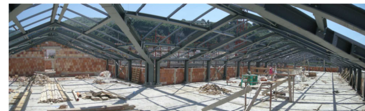
le colonne multiple d'angolo
