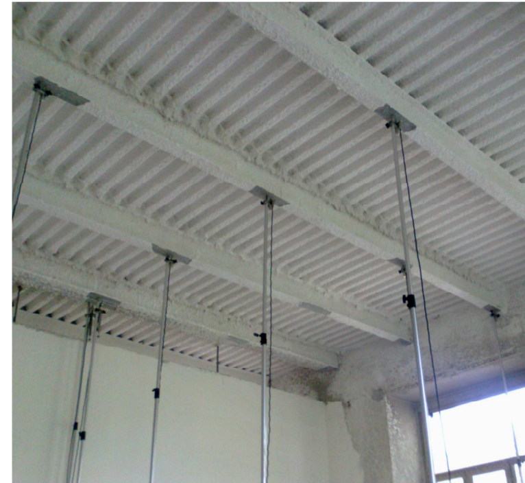
la prova di carico: il sistema di comparatori applicati all'intradosso del campo del solaio di prova
