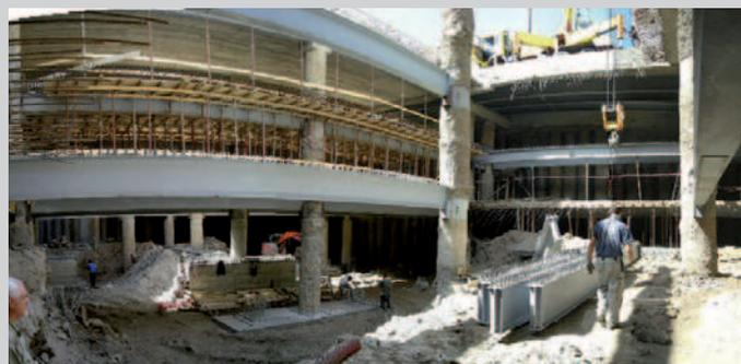
Fig. 1.11: plinto a un palo colonna e due satellite in fase di montaggio della gabbia, mentre la gru, posteggiata sull'impalcato da ponte, a traffico aperto, cala le travi a fondo scavo
