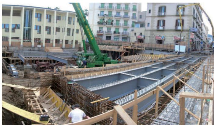
Fig. 1.1: il parcheggio occupa tutta la piazza; la parte della copertura coincidente con la strada è un ponte di prima categoria; i fabbricati circostanti insistono sul ciglio della paratia. Gli impalcati, per ridurre i tempi di realizzazione, sono in acciaio calcestruzzo.
