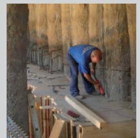
Fig. 1.7: preparazione dell'iniezione di resina
