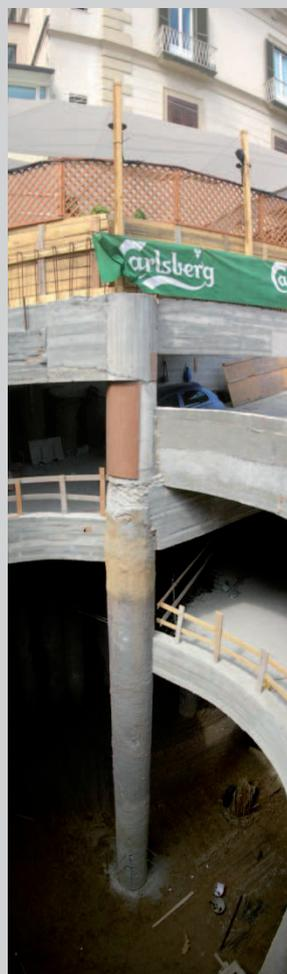
Fig. 1.8: collegamento fra palo colonna e le travi della rampa elicoidale
