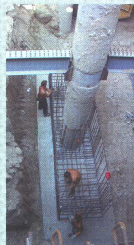
Fig.: 1.10 plinto a un palo colonna e due satelliti
