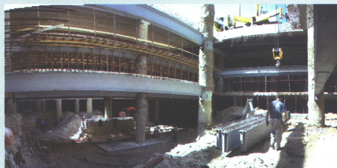
Fig. 1.11: plinto a un palo colonna e due satelliti in fase di montaggio della gabbia, mentre la gru, posteggiata sull'impalcato da ponte, a traffico aperto, cala le travi a fondo scavo
