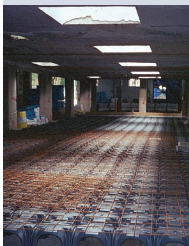
Soletta con intercapedine areata realizzata al piano terra con l'impiego di casseri in materiale plastico.
