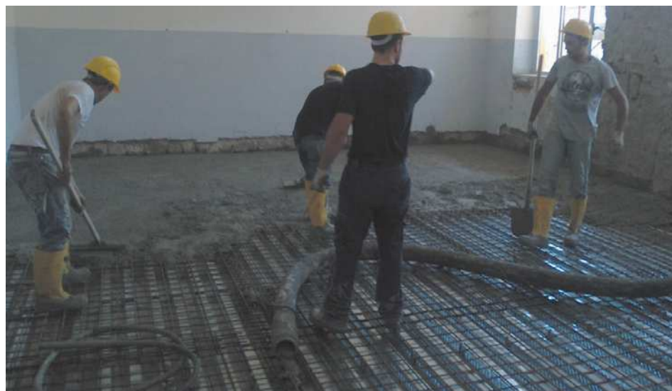
Fig. 5 Il getto della soletta e il collegamento del grip-round, dei connettori, della lamiera HI-BOND e dei profilati
