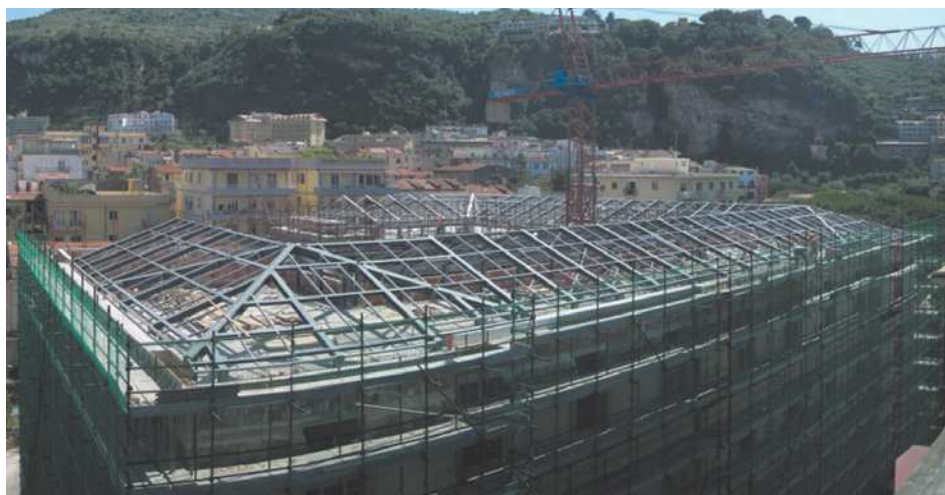
Fig.12 la copertura montata
