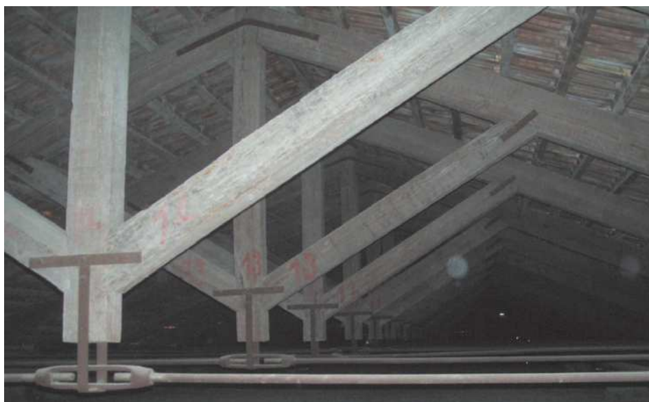
Fig.9 L'originaria copertura lignea in capriate con tirante inferiore; il sottotetto non consentiva alcuna utilizzazione
