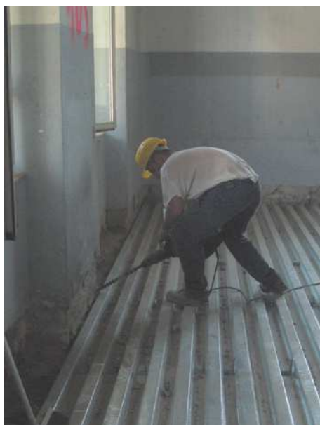
Fig. 1 Le perforazioni sub orizzontali a quota della soletta
