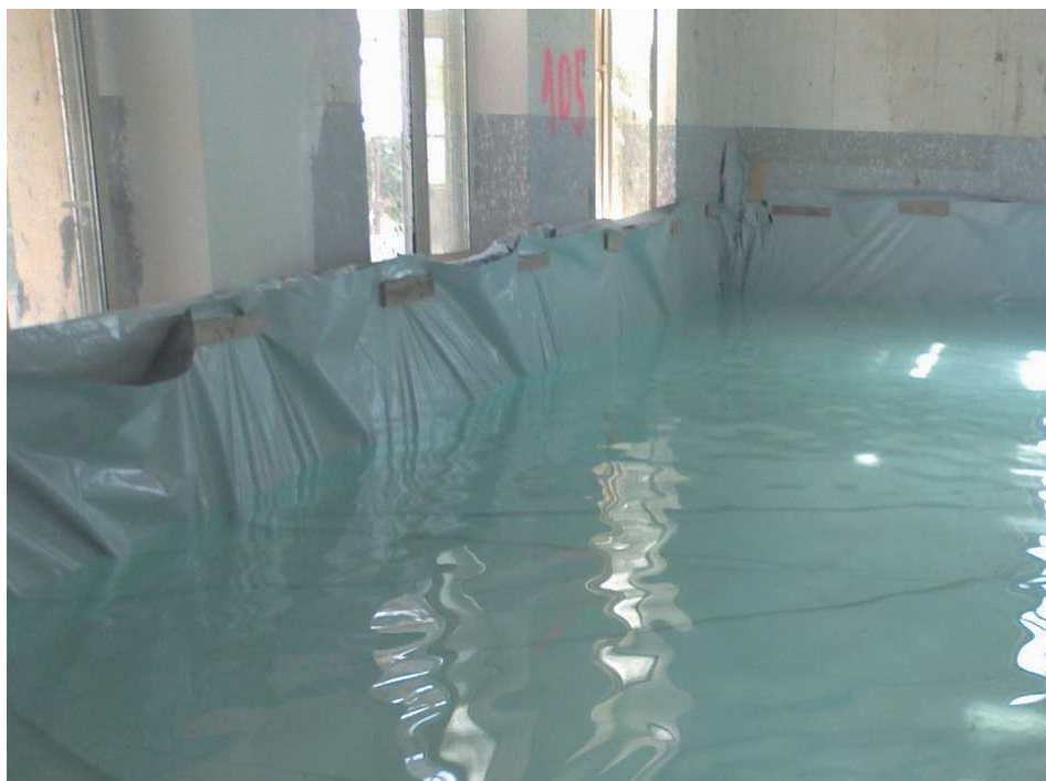
Fig.7 La prova di carico effettuata per completo allagamento di un solaio
