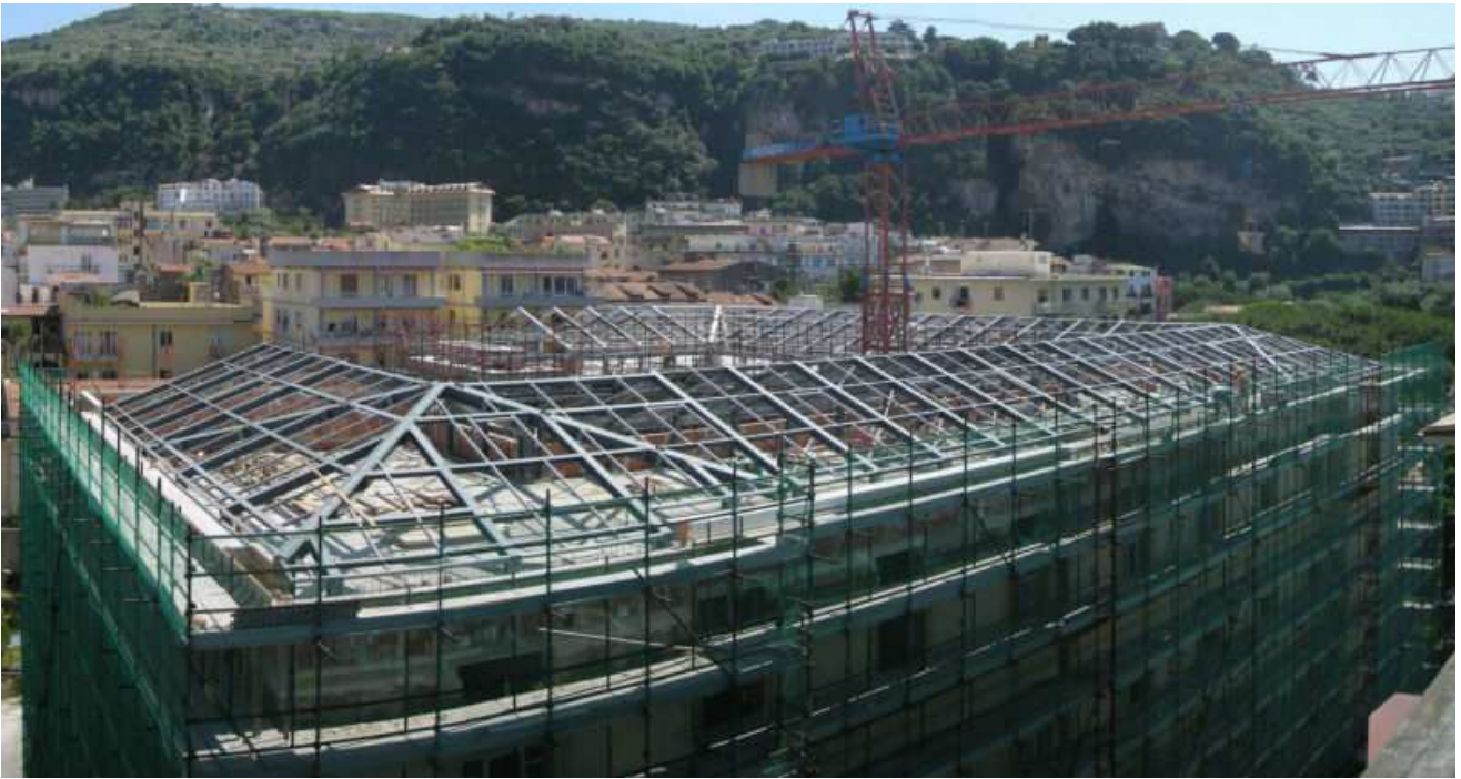
fig.12 la copertura montata
