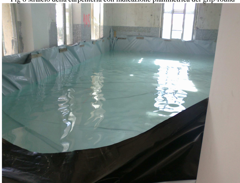
fig.7 la prova di carico effettuata per completo allagamento di un solaio
