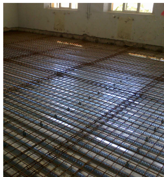
fig.2 il solaio prima del getto con connettori, rete elettrosaldata e grip-round
