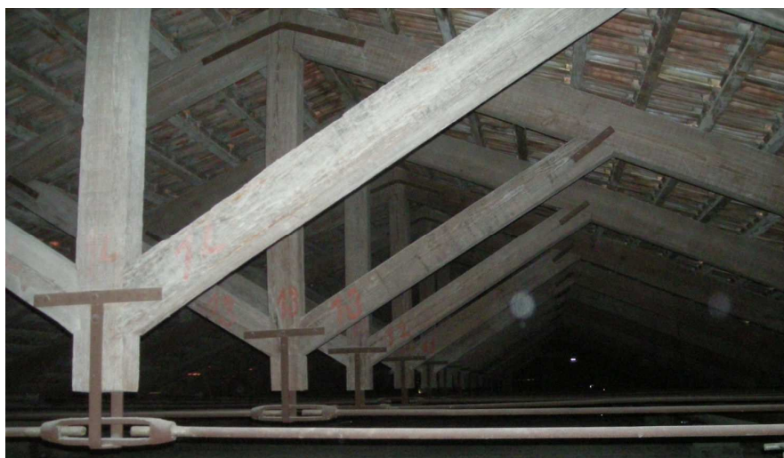
Fig.9 l'originaria copertura lignea in capriate con tirante inferiore; il sottotetto non consentiva alcuna utilizzazione
